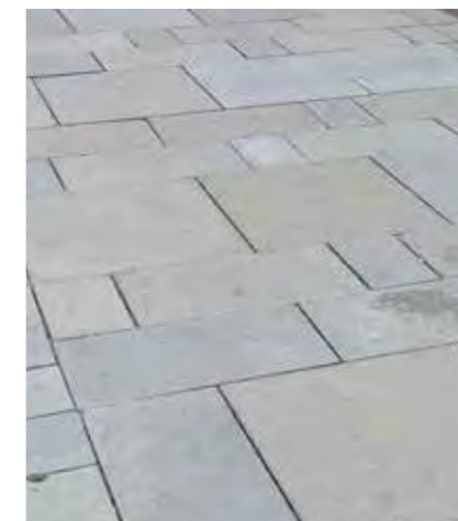
Plattans infärgning ska göras med likartade men olika varmgrå kulörer för att skapa skiftningar som ger variation.
