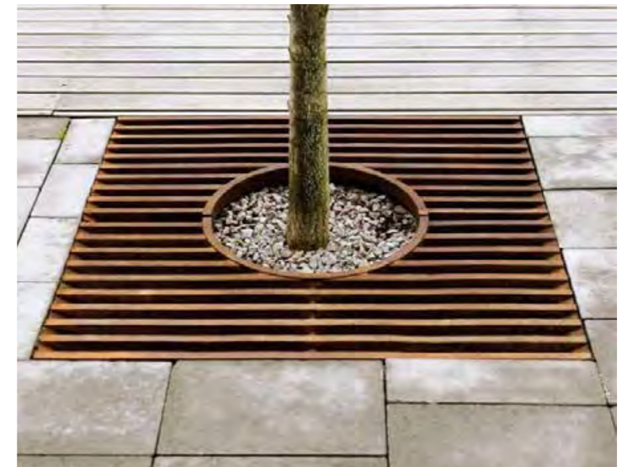
Trädgaller "DOCK-LINE" från GH FORM. Galler i gjutjärn och ram av stål. Deltavägen, Leråkersgatan och Backavägen (bildkälla: ghform.se).
